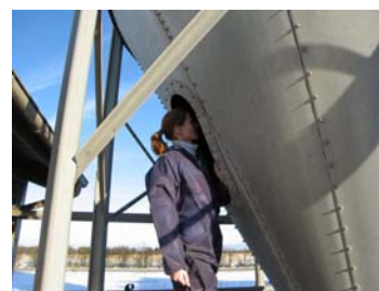
Udendørs silo med mandehul for nem inspektion
